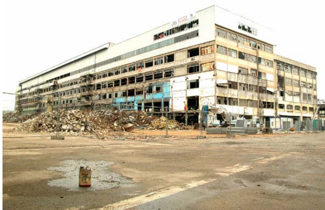
Bâtiments en destruction sur l'île Seguin tubularok.free.fr/seguin/big/09.10.04.renault.03.jpg
