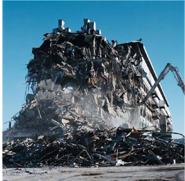
Destruction des bâtiments sur l'île Seguin © Adeline Bommart
