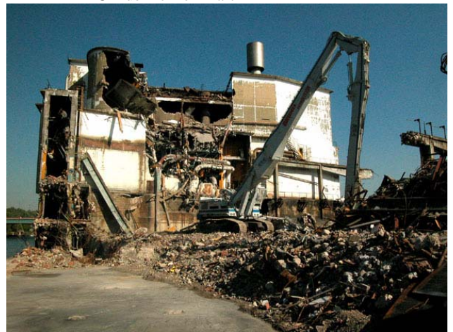
Bâtiments en destruction sur l'île Seguin tubularok.free.fr/seguin/big/24.04.04.renault.22.jpg
